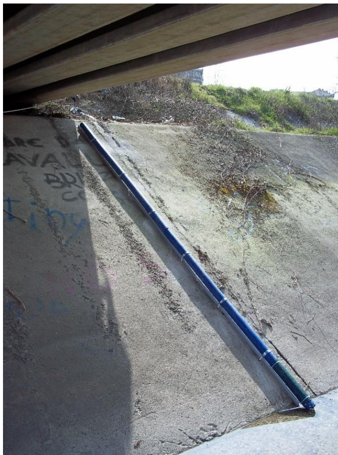
Figura 28 – Installazione del telaio per la posa della sonda all'interno del CSNO
